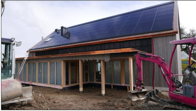
Noch sind die Bauarbeiten im Gange, hier am gedeckten Eingangsbereich.
