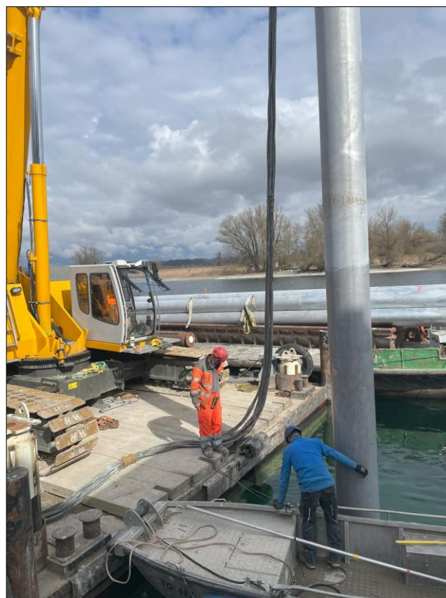
Präzisionsarbeit mit schwerem Gerät: das Einrammen der neuen Dalben ...
