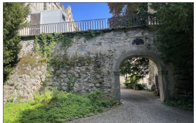
Die Verbindungsmauer zum Westturm kann erst im nächsten Sommer saniert werden.
