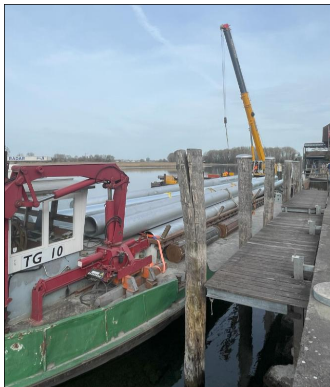
Die neuen Dalben aus Stahl wurden eben- falls über das Wasser angeliefert.
