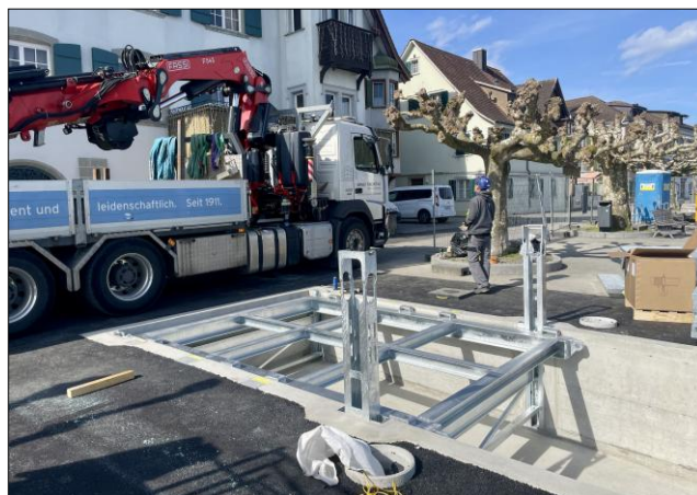
... ebenso der Einbau der Plattform.
