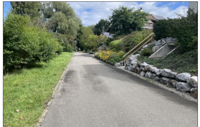
Die 3. Etappe der Werkleitungserneuerung beginnt an der hinteren Weiherstrasse.
