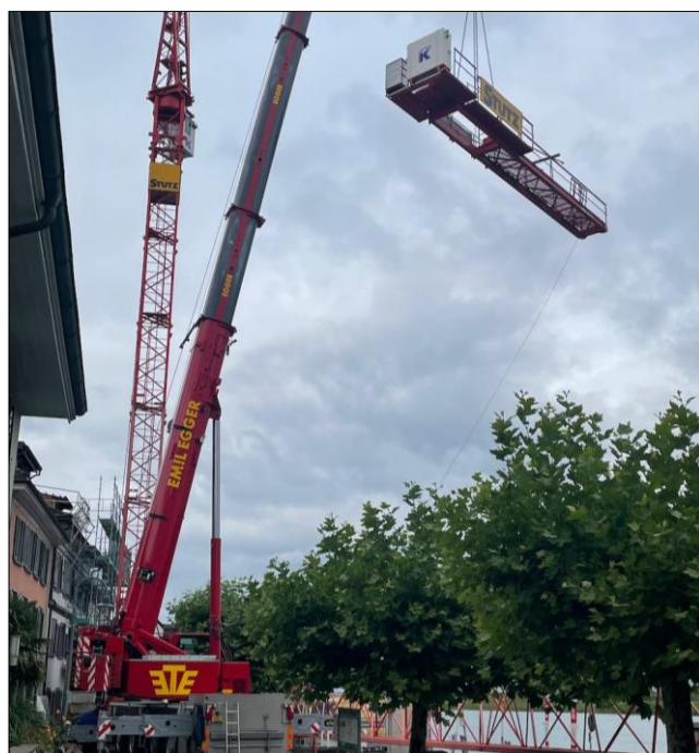
Der Kran wird montiert.
