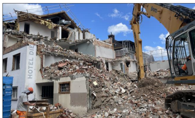
Es folgt der neuere Teil des Altbaus.
