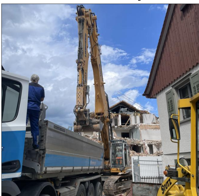
Schwerstes Gerät im Einsatz.
