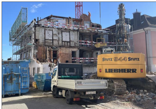
Die alten Aussenwände sind gesichert.
