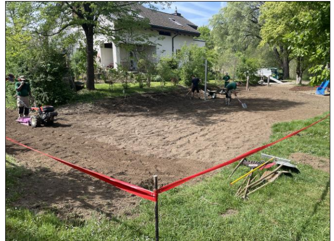
Von der Werkleitungserneuerung war und ist auch der Spielplatz betroffen. Im Zuge dessen ist der Platz zum Fussball- und Volleyballspielen ausgeebnet und der Rasen neu eingesät worden (Bild).
