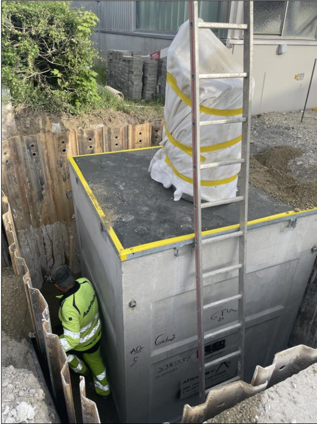
Der dritte und letzte Unterflurcontainer an der Espenstrasse ist gesetzt.
