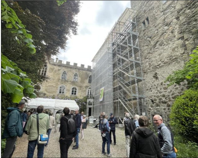
Die Mitglieder des Thurgauer Heimatschutzes erhielten auch Einblick in die laufenden Sanierungsarbeiten beim Schloss Gottlieben – hier der Westfassade.
