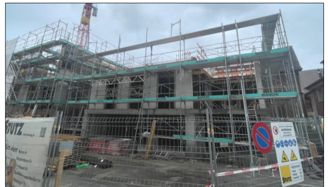
Der Umbau der «Krone» nimmt Gestalt an.
